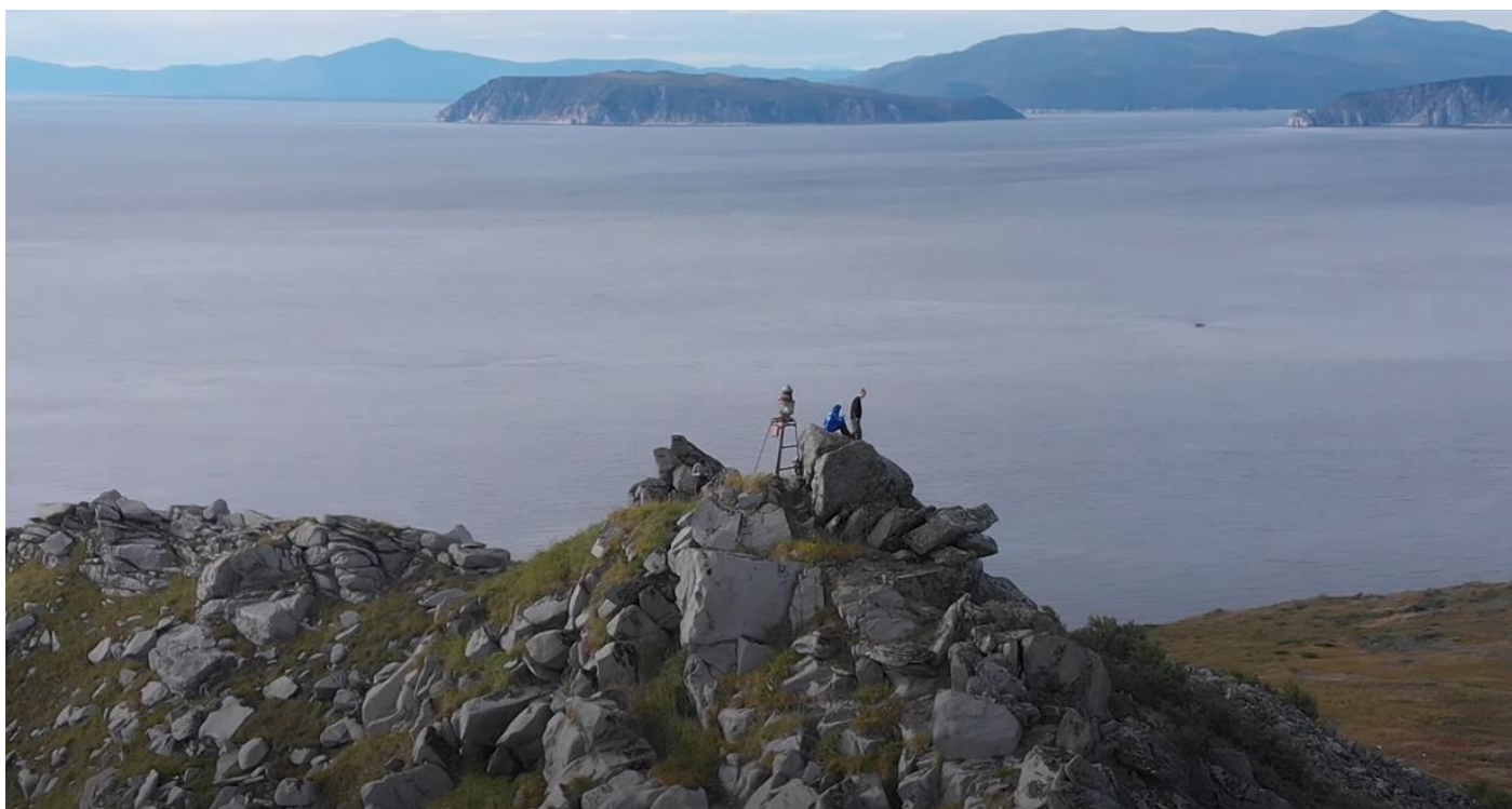
Неработающий газовый маяк № 2 Рис. № 12
