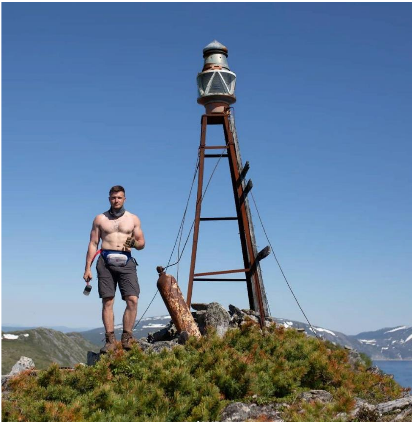
Неработающий газовый маяк №1 Рис. № 11
